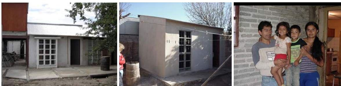
Figuras 4, 5 y 6: Prototipos fabricados con ladrillos de plásticos reciclados.
