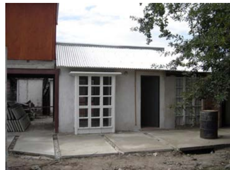
Fig. 4: Prototipo con ladrillos de PET.
