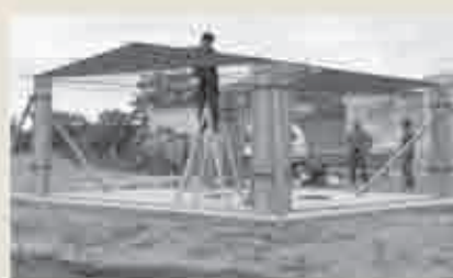
COLOCACIÓN DE VIGAS
