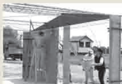
CERRAMIENTO LATERAL CON PLACAS Y VENTANAS
